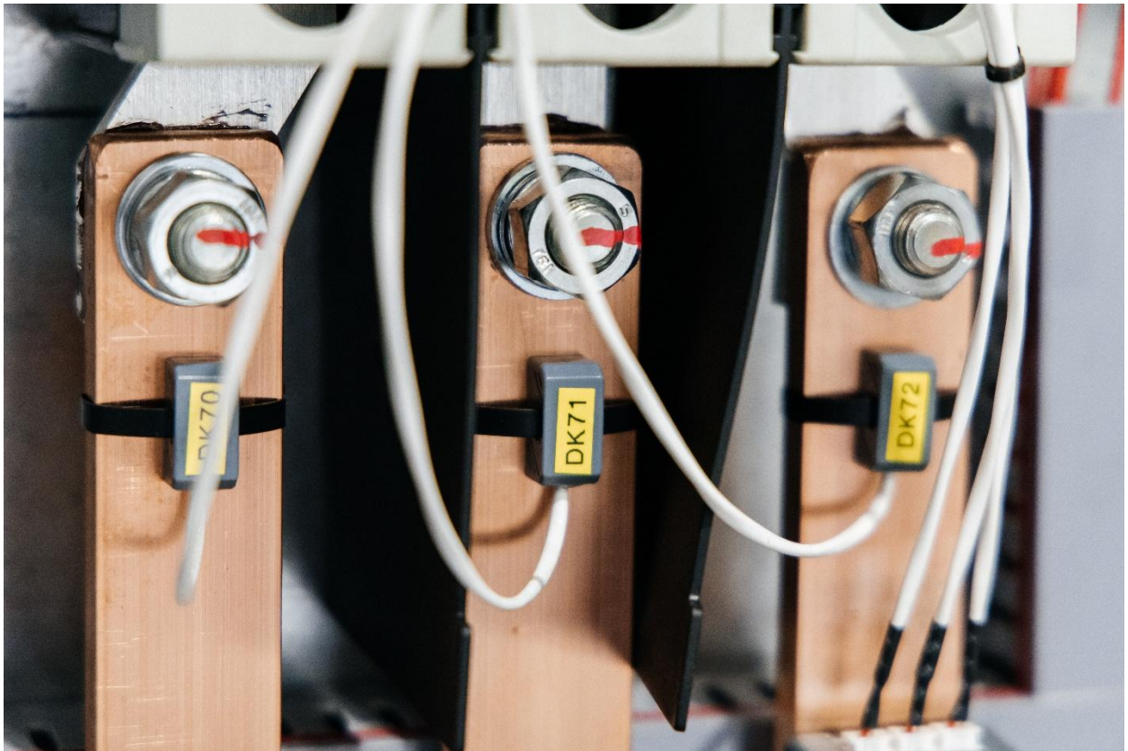
STP-S1 на контактных соединениях распределительного устройства среднего напряжения 10 кВ
